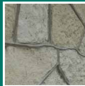
Fragment podmurówki wykonanej z kamienia elewacyjnego
