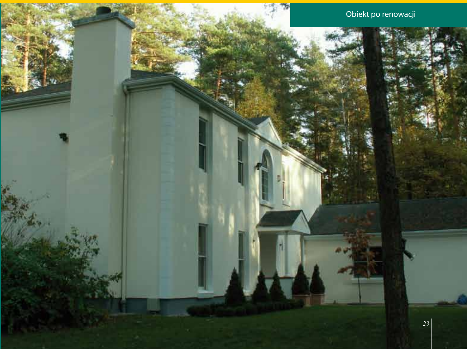
Obiekt przed renowacją
