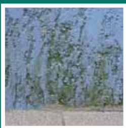
Rozwój alg na powierzchni cienkowarstwowego tynku akrylowego
