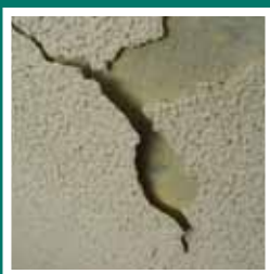
Odpadanie tynku cienkowarstwowego w wyniku łącznego stosowania komponentów BSO pochodzących z oferty różnych producentów
