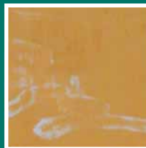
Białe wykwit wapienne – zbyt krótki czas sezonowania wyprawy mineralnej przed malowaniem
