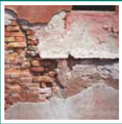
Efekty podciągania kapilarnego wody gruntowej
