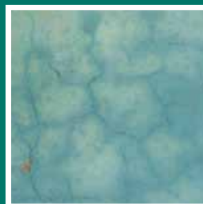
Zmiany kolorystyczne powłoki malarskiej powstałe w wyniku oddziaływania zbyt alkalicznego, niewysezonowanego podłoża
